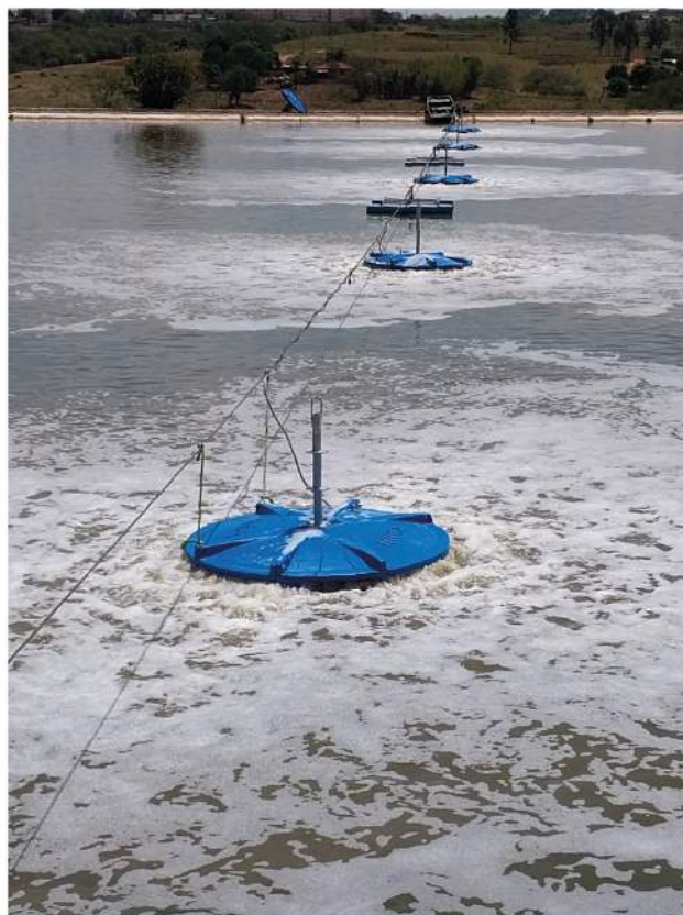
Aerador Ciclone operando em uma aplicação de saneamento
