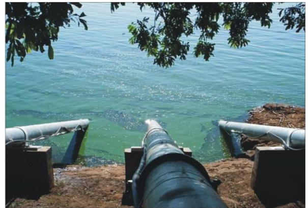
Figura 03 – Instalação de Bombas Submersas
