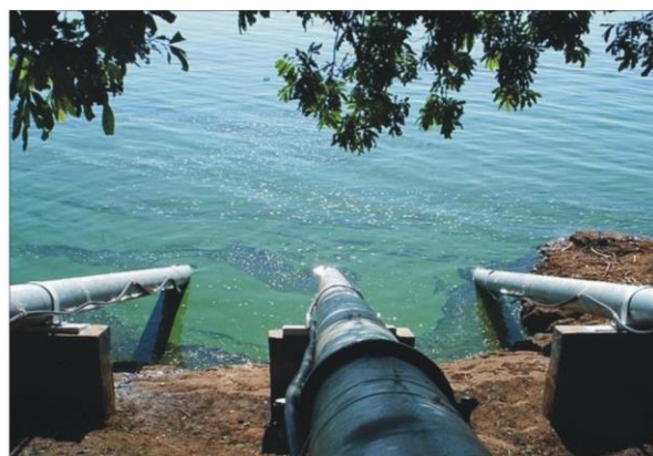
Figura 03 – Instalação de Bombas Submersas
