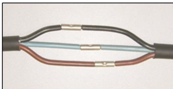
Figura 24 - Empalme paso 2
