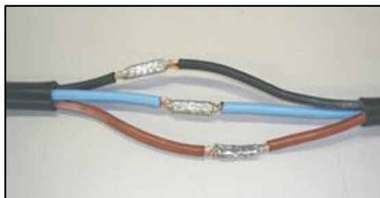
Figura 25 - Empalme paso 3
