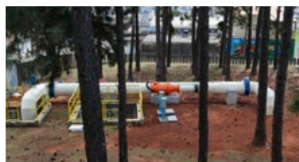
Brás Cubas (Mogi das Cruzes) TGA-1195/92 Instalación en paralelo Caudal: 550 L/s | Pot. Inst.: 92kW Presión Dif./Caída Neta: 20 mca Efic. Hidráulica: 91% Control de Flujo | Minigeneración
