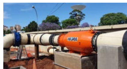
Ilaquera TGA-1611/145 Instalación en serie Caudal: 1500 L/s | Pot. Inst.: 145kW Presión Diferencial/Caída Neta: 12 mca Efic. Hidráulica: 85,8% Control de Flujo | Minigeneración
