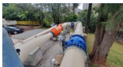
Mirante TGA-1238/300 Instalación en paralelo Caudal: 900 L/s | Pot. Inst.: 300kW Presión Diferencial/Caída Neta: 48 mca Efic. Hidráulica: 88,7% Control de Flujo | Minigeneración
