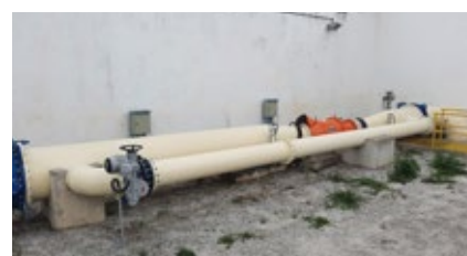
Freguesia do Ó TGA-1295/75 Instalación en serie Caudal: 480 L/s | Pot. Inst.: 75kW Presión Diferencial/Caída Neta: 16 mca Efic. Hidráulica: 91% Control de Presión | Microgeneración
