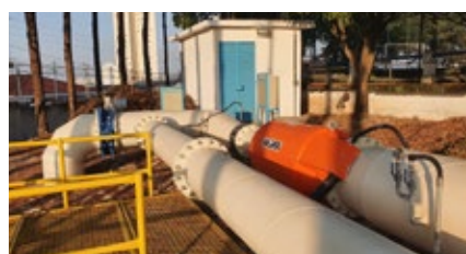
Vila Maria TGA-119/130 Instalación en paralelo Caudal: 445 L/s | Pot. Inst.: 130kW Presión Diferencial/Caída Neta: 39 mca Efic. Hidráulica: 86,6% Control de Flujo | Minigeneración
