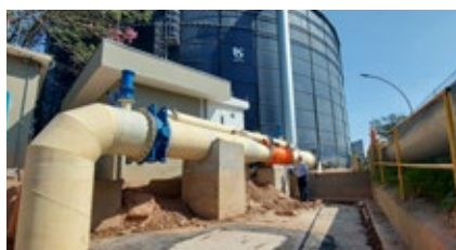
Capão Redondo TGA-1317/110 Instalación en paralelo Caudal: 850 L/s | Pot. Inst.: 110kW Presión Diferencial/Naída Neta: 17 mca Efic. Hidráulica: 89,3% Control de Flujo | Minigeneración
