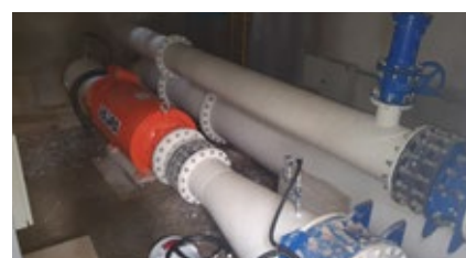
Pinheiros TGA-1353/220 Instalación en paralelo Caudal: 645 L/s | Pot. Inst.: 220kW Presión Diferencial/Caída Neta: 48 mca Efic. Hidráulica: 85,3% Control de Flujo | Minigeneración
