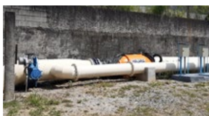
Jardim das Nações (Diadema) TGA-1595/92 Instalación en paralelo Caudal: 1200 L/s | Pot. Inst.: 92kW Presión Diferencial/Caída Neta: 8 mca Efic. Hidráulica: 84,9% Control de Flujo | Minigeneración
