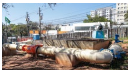
Vila Sônia TGA-1137/55 Instalación en paralelo Caudal: 250 L/s | Pot. Inst.: 55kW Presión Diferencial/Caída Neta: 30 mca Efic. Hidráulica: 84,6% Control de Flujo | Microgeneración
