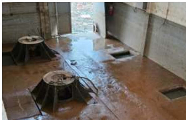
Os motores foram retirados para não queimarem, tornando a casa de bombas inoperante.
