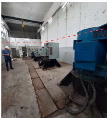
Nível da água da enchente dentro da casa de bombas.
