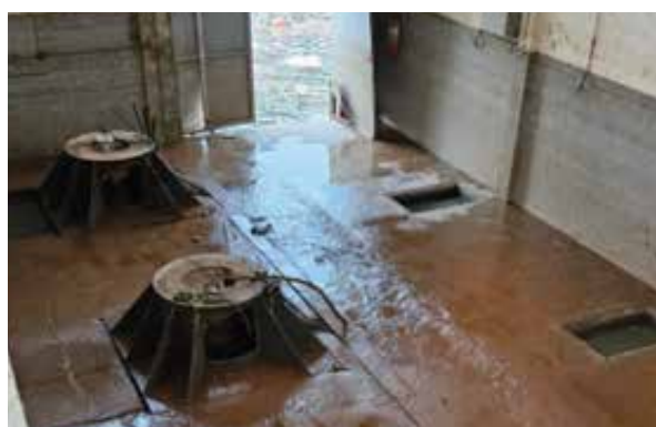
Necesidad de desmontar los motores para evitar daños, dejando inoperativa la sala de bombas.
