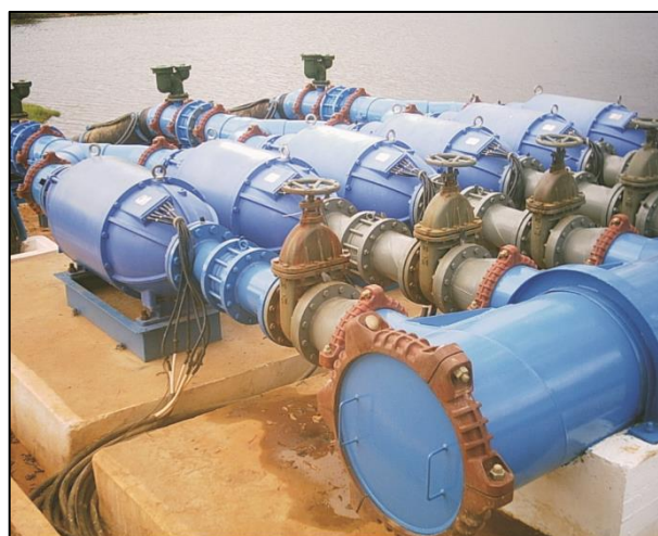
Figura 3 – Bombas Anfíbias em sistema modular
